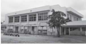
長洲小体育館
